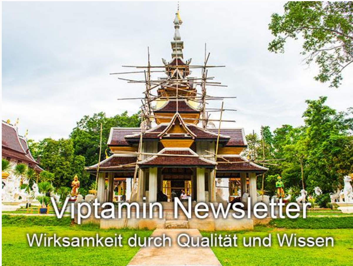
Gerüst an einem idyllischen Waldkloster in Thailand
